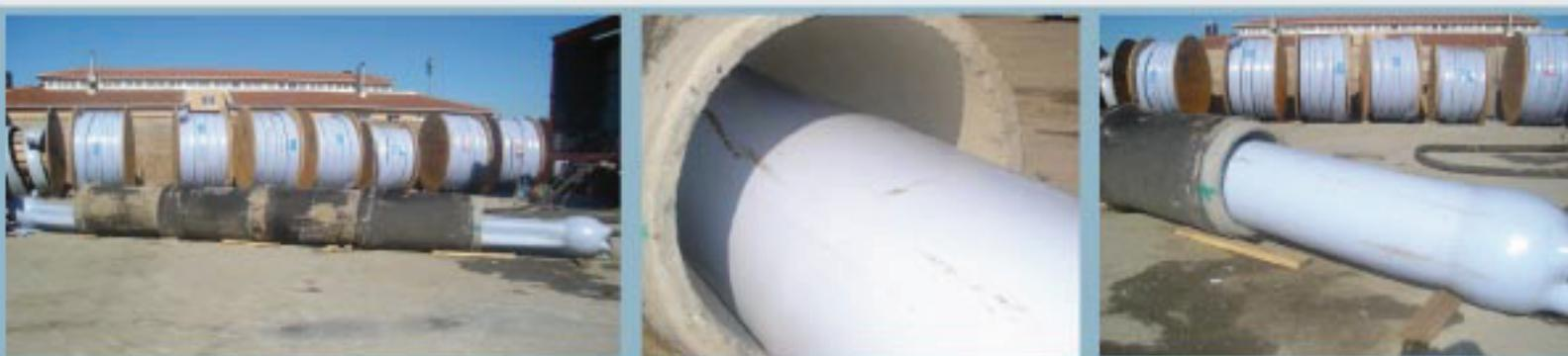
Buhar Ve Basınç Etkisi İle Malzeme Şekillenerek Kanala Tam Oturma Gerçekleşir
